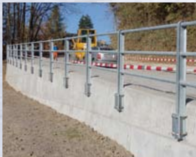
Eingegossene vertikale Verankerung
