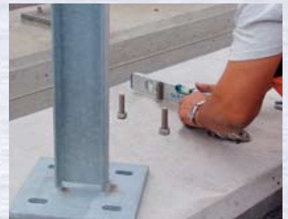
Montage der Leitplanken mit WALSER-Verankerungen am Autobahnviadukt St.Gallen
