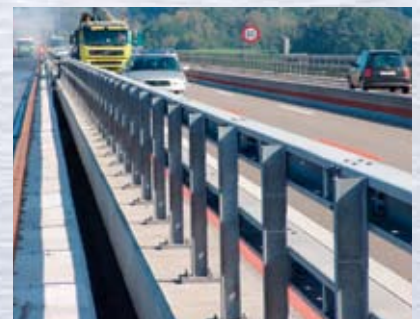
Das fertig montierte Geländer am Autobahnviadukt St.Gallen
