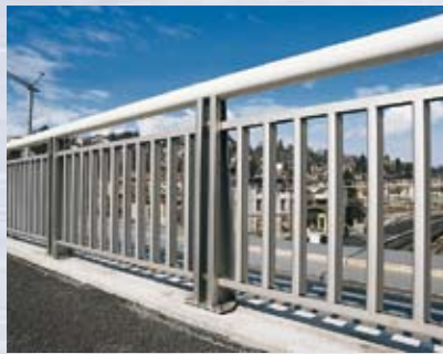
Brückengeländer mit WALSER-Verankerungen Leonhardsbrücke St.Gallen
