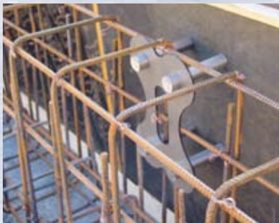
Vertikale Verankerung vor dem Eingiessen
