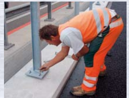
Nach präziser Ausnivellierung wird die Stütze montiert
