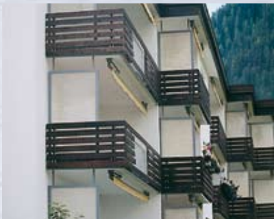
Balkongeländer mit WALSER-Verankerungen in Davos
